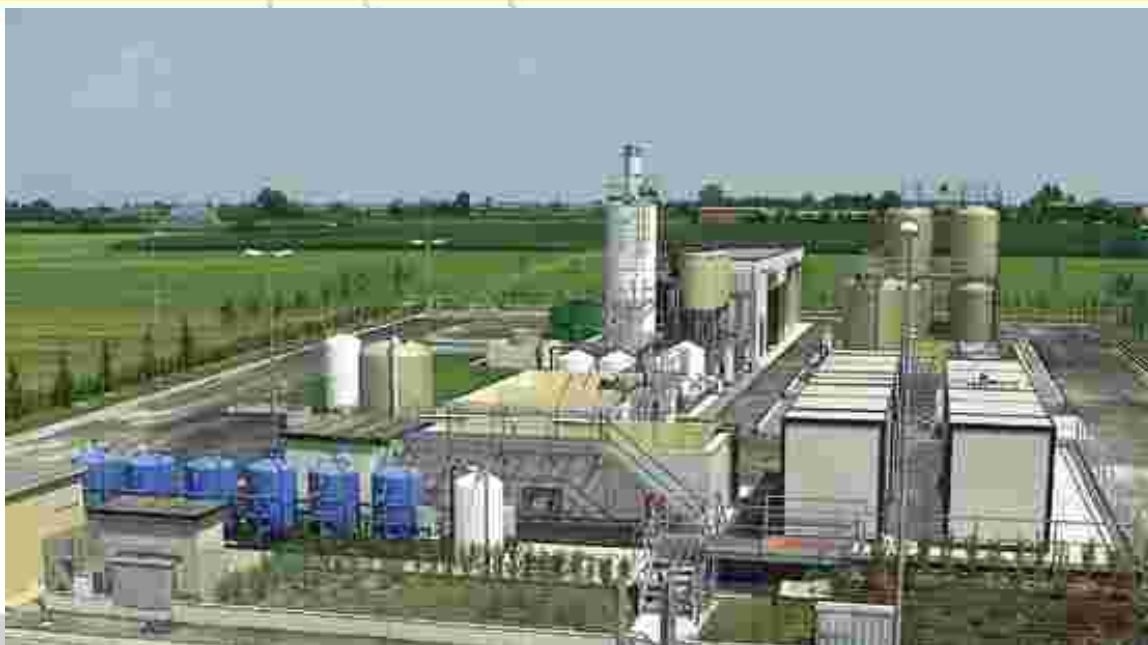
Batteria serbatoi e decantatori per impianto smaltimento rifiuti industriali.
